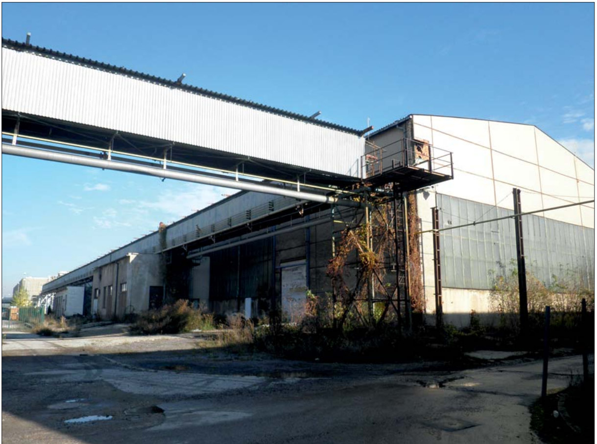
Foto 2: Dotknutá priemyselná hala - pohľad od západu
